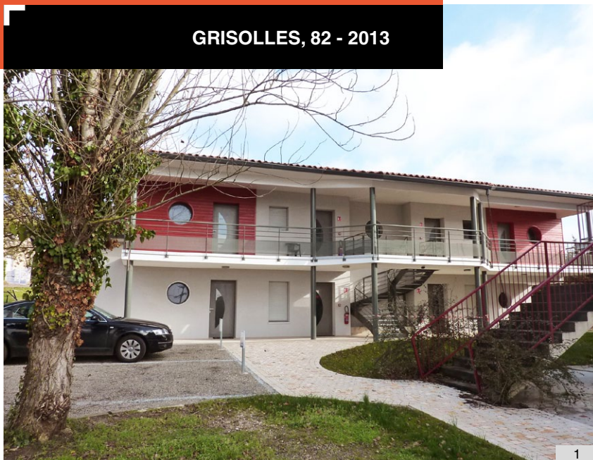
1. Vue générale de l'extension de l'hôtel
